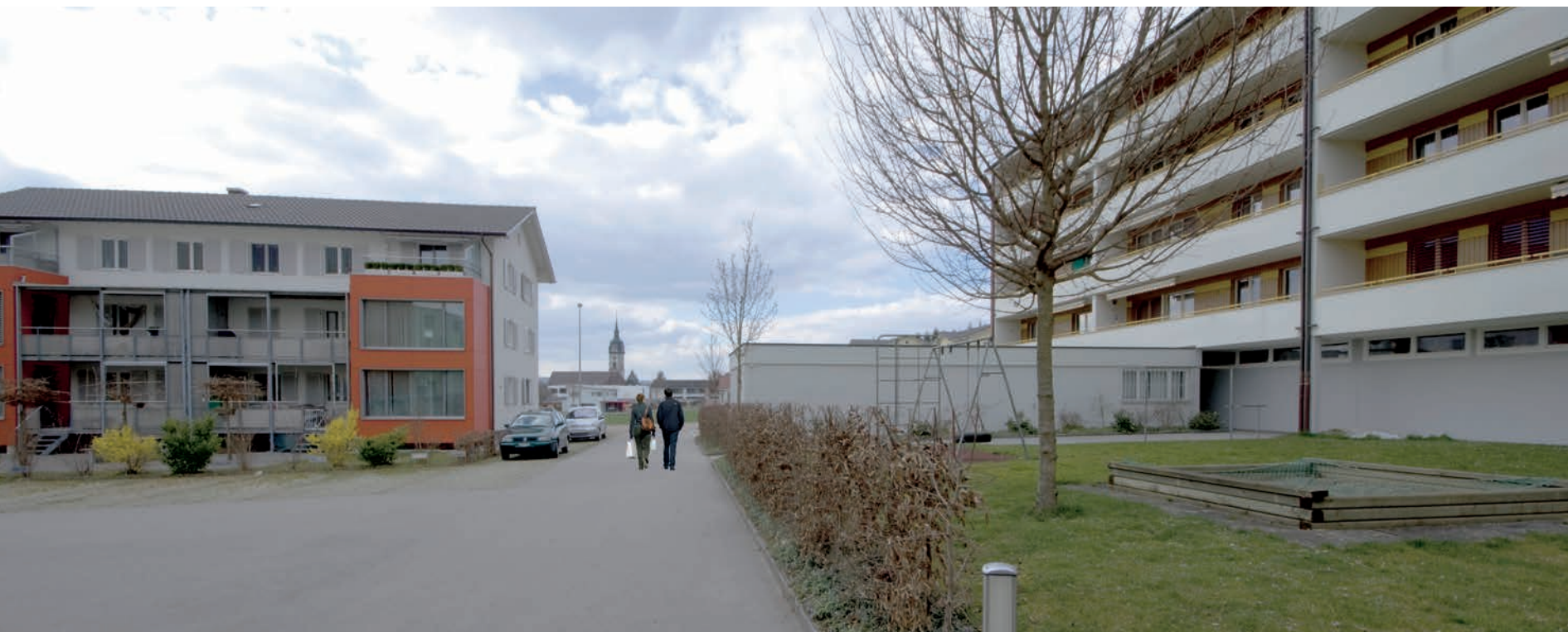
Zufahrt Parkplätze/Innenhof Sonnmattliegenschaften
